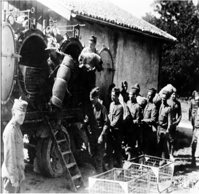
Image7: Le désinfecteur à vapeur Foden Thresh en travail[30]
